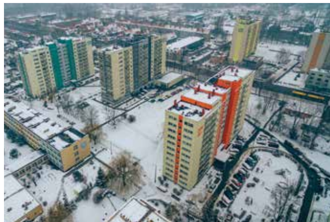
Spółdzielcze bloki z lat 70. przy ul. Wolności i ul. Pokoju, rejon ADS „Zachód”
