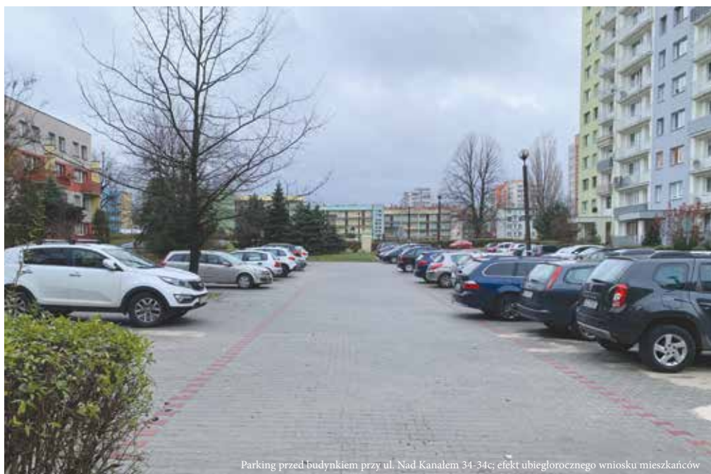
Parking przed budynkiem przy ul. Nad Kanalem 34-34c; efekt ubiegłorocznego wniosku mieszkańców
